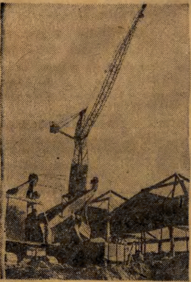
Budowa Fabryki Armatur w Borku Fałęckim pod Krakowem postępuje szybko naprzód. Na zdjęciu: fragment budowy. Na pierwszym planie kopaczka radziecka, w tle bierająca ziemię z wykopu pod stację pomp. CAF — fot. Kondracki
