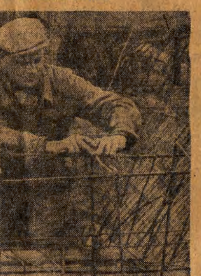
W ramach rozbudowy przemysłu, w Ozorkowskich Zakładach Przemysłu Bawełnianego buduje się nową wielką wykończalnię i elektryczną zakładową. Na zdjęciu: zbrojarze, Stefan Jurek i Michał Kozakiewicz, przy zbrojeniu bunkra nawęglającego.
