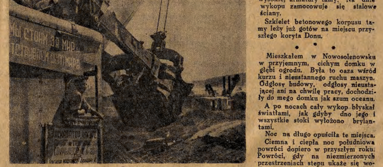
Ekskawatorki przy pracy fot. CAF.
