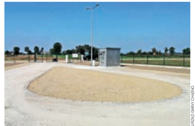
Wykonanie zrzutu było jedną z ostatnich inwestycji gminy Chaśno zrealizowanych w 2018 roku.
