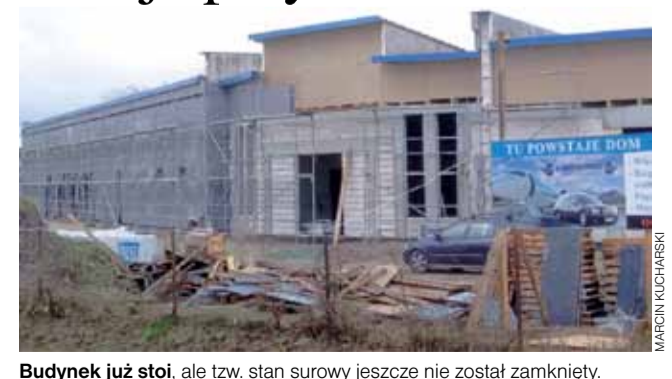
Budynek już stoi, ale tzw. stan surowy jeszcze nie został zamknięty.
