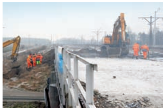
W poniedziałek, 21 stycznia rozpoczęły się prace rozbiórkowe płyty nośnej, na której były ułożone tory.
