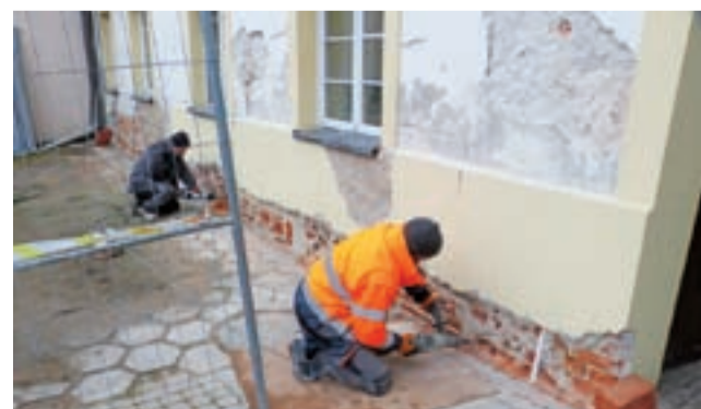
Prace, które widzimy na zdjęciu, polegają na odkuwanie fundamentów w celu sprawdzenia ich stanu technicznego przed późniejszym położeniem izolacji ścian fundamentowych.
