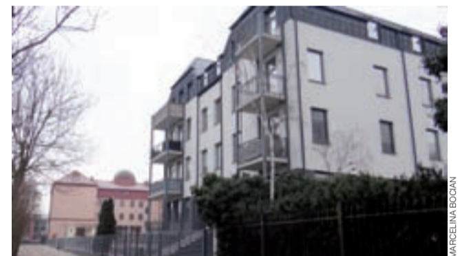
Prace przy ulicy Akademickiej deweloper rozpoczął już kilka lat temu od przebudowy i zaaranżowania na blok mieszkalny starego rektoratu „Mazowieckiej”. Aktualnie jest on już wykończony i zamieszkały (pierwszy plan). Za nim w tle widać główny gmach starej szkoły, który zostanie wyburzony, by na jego miejsce postawić nowy budynek.
