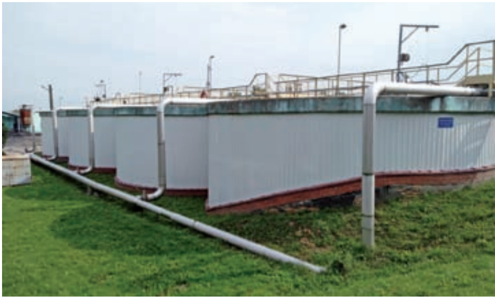
Oczyszczalnia ścieków składa się z wielu obiektów, a każdy z nich spełnia inną rolę. Na zdjęciu komory nitryfikacji, w których dochodzi do napowietrzania ścieków.
