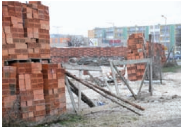
Przewizoryczna brama na teren budowy przy ul. Tuszewskiej, gdzie w przyszłości ma powstać budynek mieszkalny.
