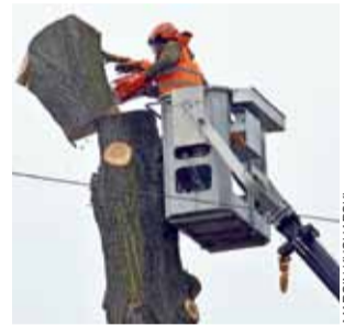
Z uwagi na bliskość m.in. linii energetycznych oraz trakcji kolejowej, drzewa musiały być ścinane po kawałku.
