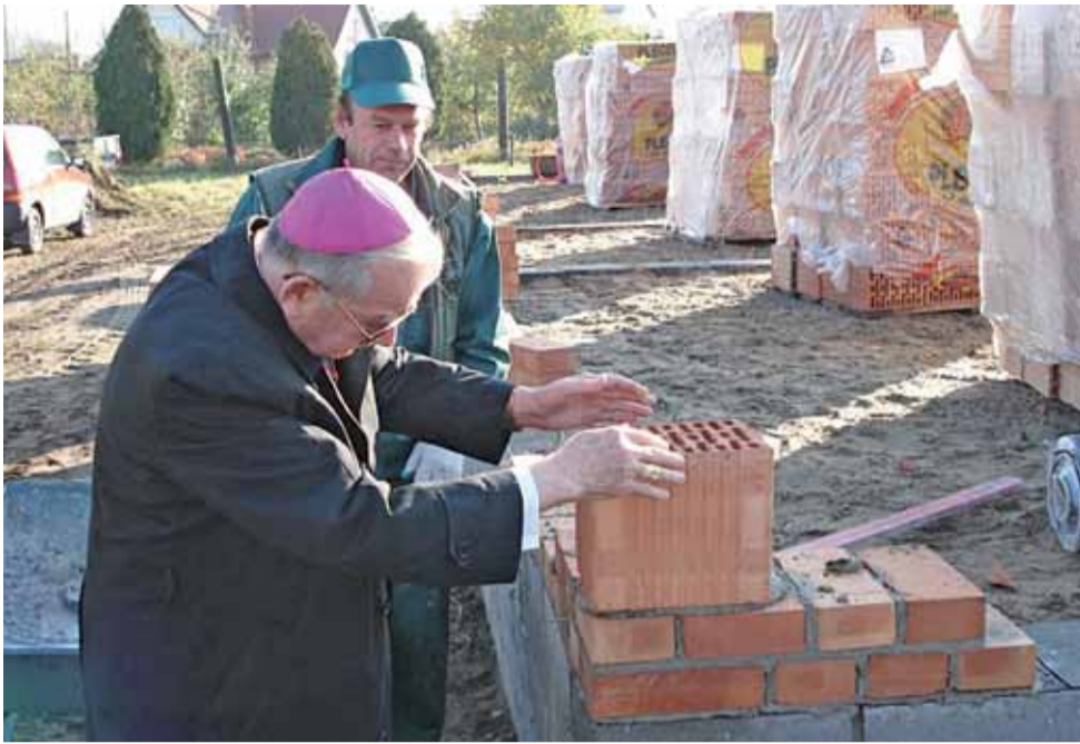
Plac budowy domu Fundacji Czyni Dobro na Bratkowicach, 20 października 2007 r.
