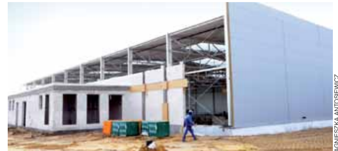
Postępują prace przy budowie zakładu Hellyar Plastics przy ul. Małszyce w Łowiczu.
