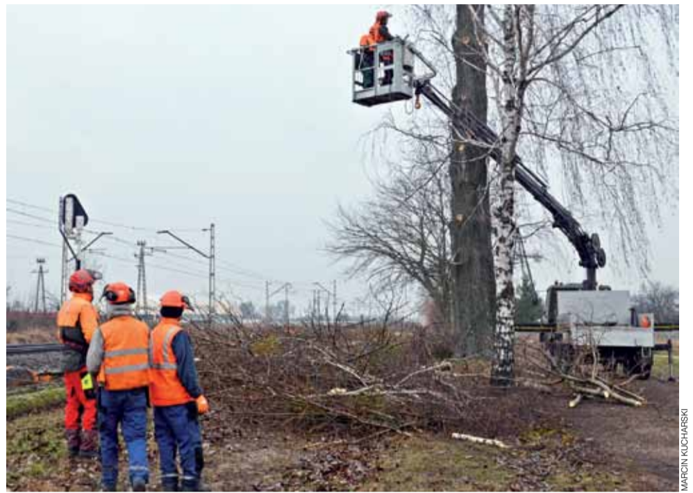
W czwartek, 21 lutego, ekipa pilarzy pracowała na odcinku pomiędzy torami a marketem Dino na Korabce.
