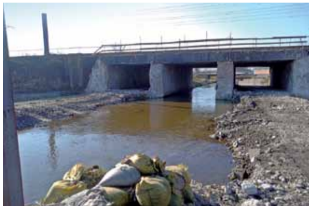
Znaczna część mostu od strony ul. Bolimowskiej już została zburzona.
