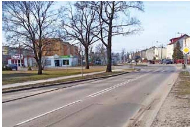
Ulica Topolowa, widok w stronę cmentarza Emus. Ścieżka rowerowa ma powstać po lewej stronie.
