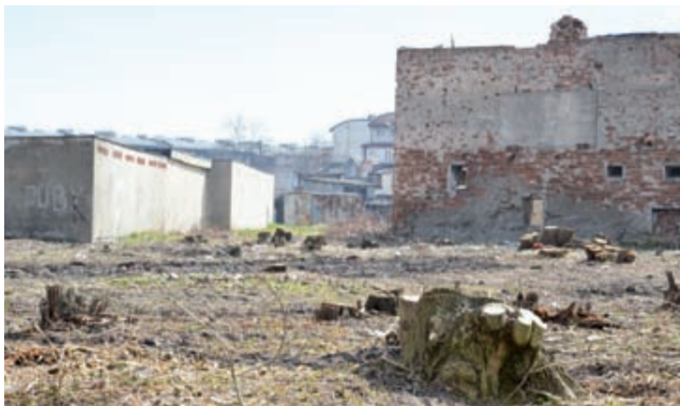
Widok od ul. Warszawskiej na teren, gdzie już za kilka tygodni rozpocznie się budowa nowego odcinka ul. Bolimowskiej. Budynek po prawej zostanie wyburzony, po lewej widać garaże wzdłuż których powstanie ulica.
