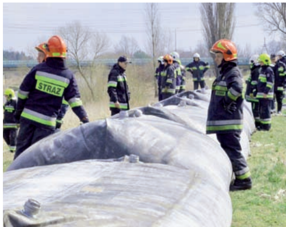
Strażacy z Łowicza, Łęczycy, Poddębic i Kutna ćwiczyli m.in. z użyciem zapór wypełnionych wodą.
