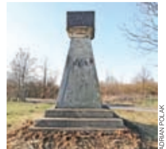
Słup w Patokach po ostatnich pracach porządkowych.
