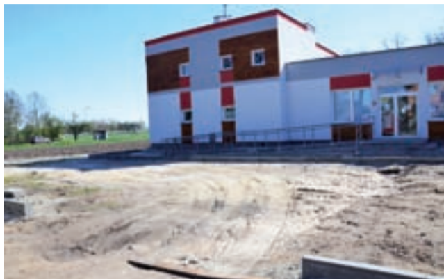
Trwają prace nad zagospodarowaniem terenu wokół Centrum Kultury w Boczkiach Chełmońskich.
