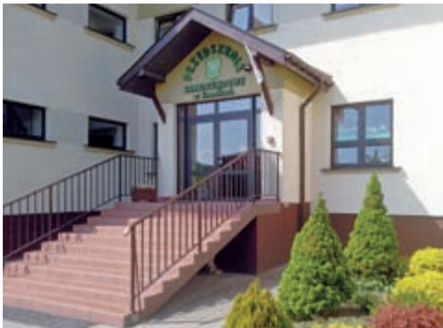
Przedszkole w Sannikach mieści się w tym miejscu od 2009 roku.
