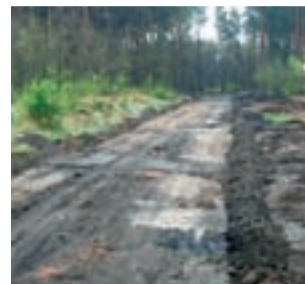
Wykop pod drogę pożarową zostanie wypełniony tłuczniem.
