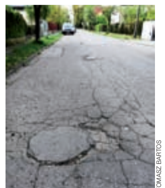
Nawierzchnia ul. Pałacowej od kilku lat wymaga naprawy, obecnie niemal cała jest spękana.
