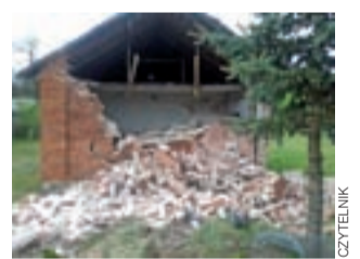
Zniszczony budynek po uderzeniu Porsche.
