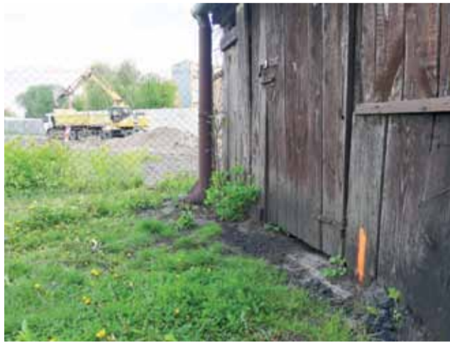
Na ścianie komórki, stojącej na podwórku Pani Aliny, widać ślad, którym geodeci wyznaczyli przebieg pasa drogowego.
