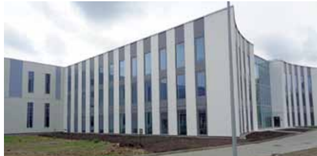
Nowoczesna hala produkcyjna jest już gotowa.
