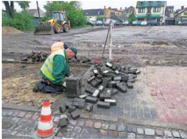
Pracownicy ZUM w ramach zagospodarowania placu przy ul. Koziej, poprawiają także wjazdy prowadzące na niego od strony ul. Sybiraków i Podrzecznej.
