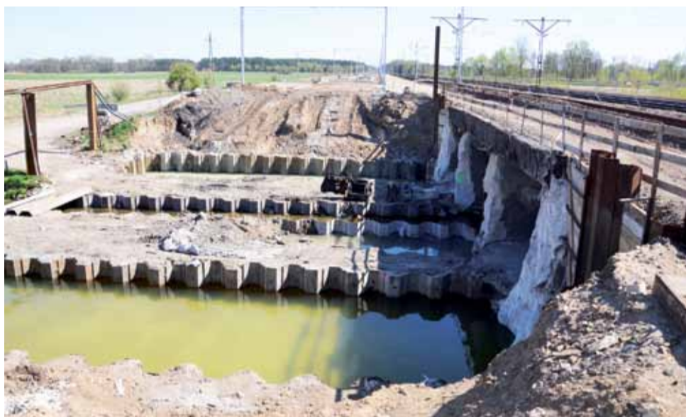
Połowa mostu nad ul. Arkadyjską i rzeką Zwierzyniec jest rozebrana.
