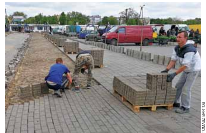
Prace przy budowie wiaty rozpoczęły się od rozebrania nawierzchni w miejscu gdzie ona powstanie.
