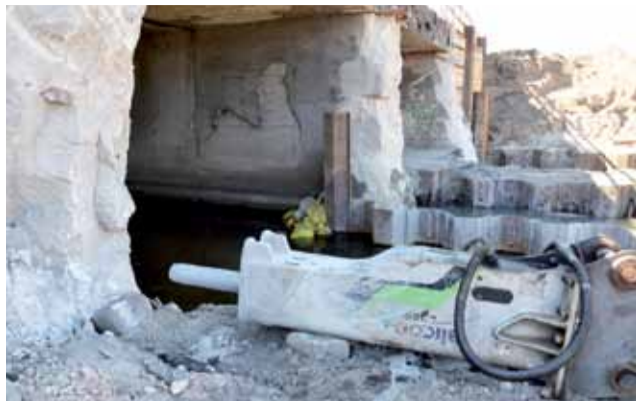
Podpory płyty nośnej mostu były burzone z wykorzystaniem takich oto potężnych młotów pneumatycznych montowanych na koparkach.
