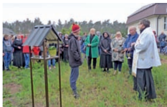
Na placu budowy Domu Mocarzy powstała kapliczka z figurą św. Józefa. Została ona poświęcona podczas uroczystej inauguracji budowy.
