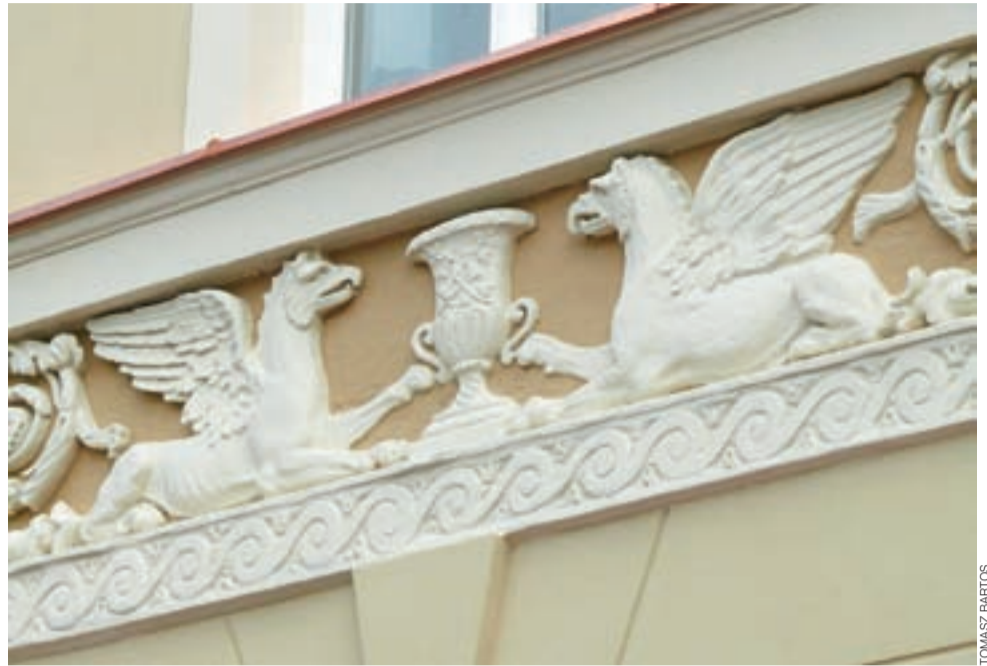
Gryfy na elewacji łowickiego ratusza stały się po remoncie lepiej widoczne.
