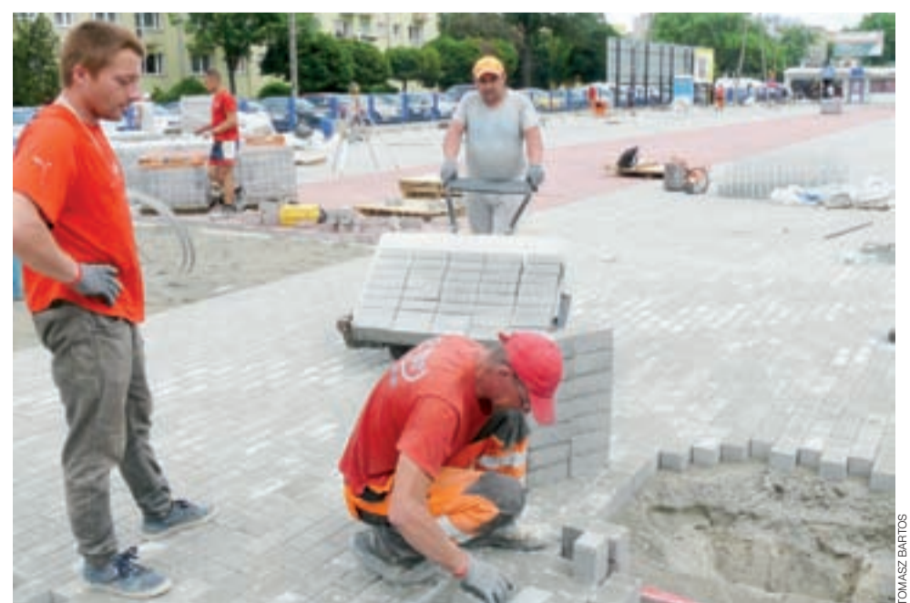
Pracownicy firmy Wig-Kost w czasie układania ostatniego fragmentu nawierzchni pod wiatę targową.
