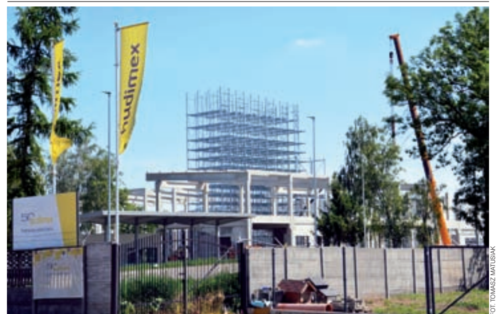
Postępują prace nad rozbudową zakładu Agros Nova w Łowiczu. Działa już nowa hala produkcyjna. Na zdjęciu widać konstrukcję magazynu wysokiego składowania, który ma być oddany do użytku w przyszłym roku. tm
