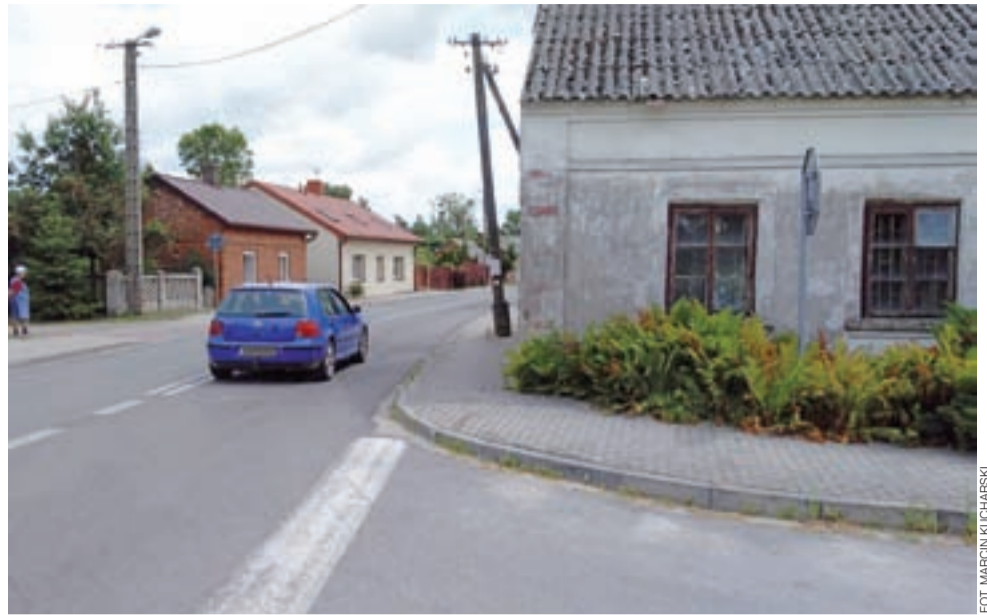
Budynek poważnie ogranicza widoczność na skrzyżowaniu w Osmolinie.
