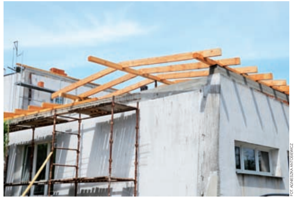
Przebieg prac nad remontem dachu w Popowie można było oglądać m.in. podczas gminnego podsumowania roku szkolnego, jakie odbyło się w tej szkole 20 czerwca.
