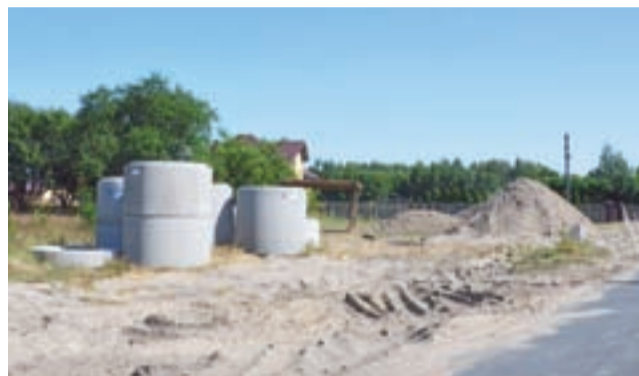
W Parmie trwają prace nad budową kanalizacji sanitarnej.
