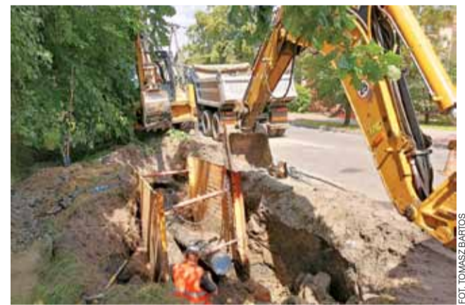
Prace na ul. Legionów – w wykopie widać rurę w specjalnej zbrojonej osłonie.
