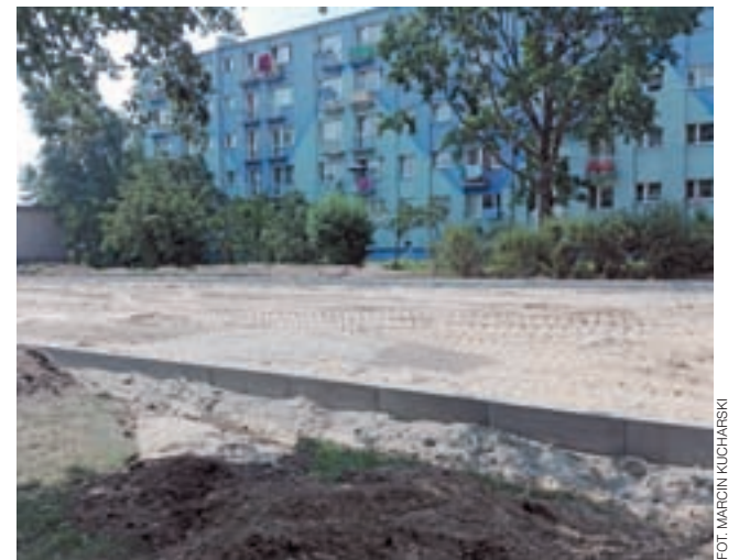
Prace przy budowie parkingu pomiędzy blokami na Broniewskiego mają potrwać jeszcze ok. 2-3 tygodnie.
