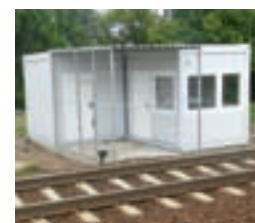
Konstrukcja nowego obiektu już stoi, ale jeszcze nie jest wyposażona.
