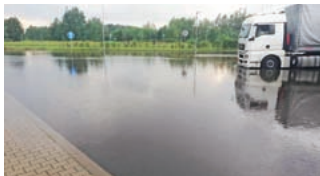
Zalane parkingi i samochody stojące w wodzie – tak wyglądała sytuacja na MOP-ach autostradowych Parma i Polesie.
