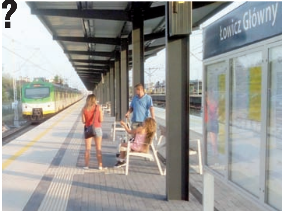
Nowy peron nr 1 na dworcu Łowicz Główny już „przyjmuje” pociągi.
