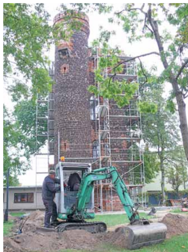
Na terenie parku przy baszcie gen. Stanisława Klickiego prowadzone są wykopy, w których układane są kable, które zasilą latarnie.
