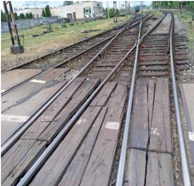
Przejazd kolejowo-drogowy przy dworcu Łowicz Przedmieście.
