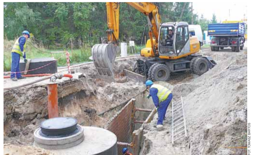
Głębokie wykopy na wąskiej ulicy Czajki, wykluczają ruch samochodów.
