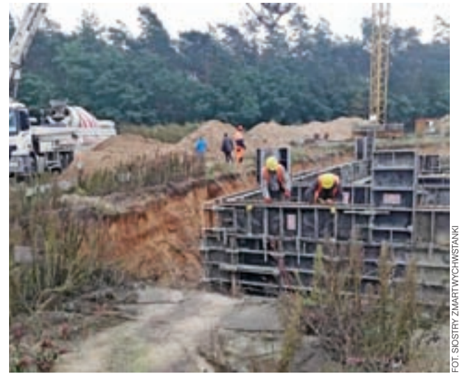
W płyty fundamentowe Domu Mocarzy wlewo 1,152 tony betonu.
