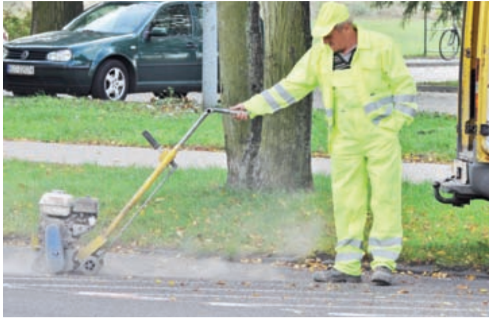
Przed malowaniem nowych linii stare – ale ciągle jeszcze widoczne – zostały sfrezowane.
