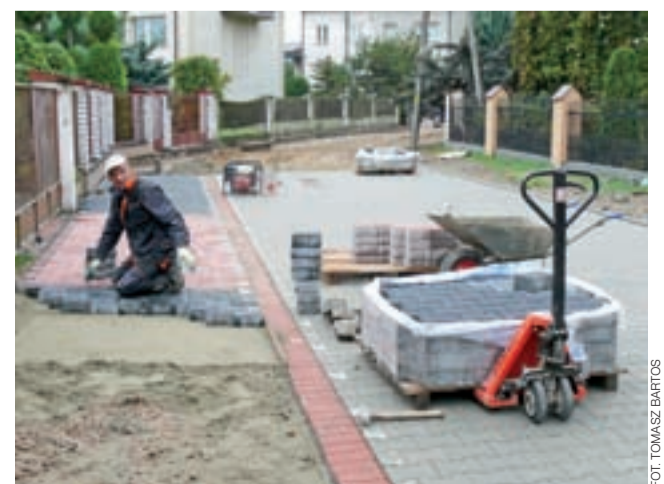
Na 80-metrowym odcinku ulicy Dębowej układana jest nawierzchnia.
