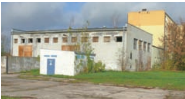
Kotłownia przy bloku nr 44 na os. Bratkowice, na pierwszym planie widać stację transformatorową, która może poważnie przeszkadzać w budowie przyszłego bloku.
