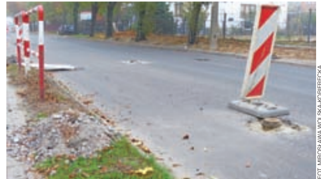
Tak wyglądała nawierzchnia ul. Armii Krajowej po położeniu wyrównawczej warstwy asfaltu, a przed położeniem ścieralnej.
