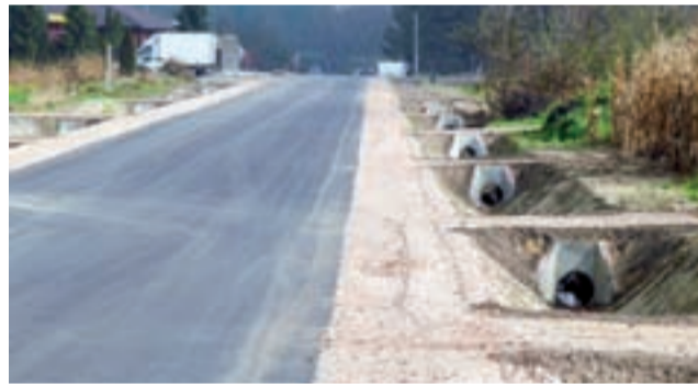
Oddana do użytku droga w Kompinie, pozwoli na zagospodarowanie wielu działek budowlanych, które przy niej się znajdują.
