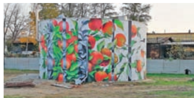
Przepompownia ścieków przy ul. Piłsudskiego w Łowiczu z graffiti autorstwa „Tybera”.
