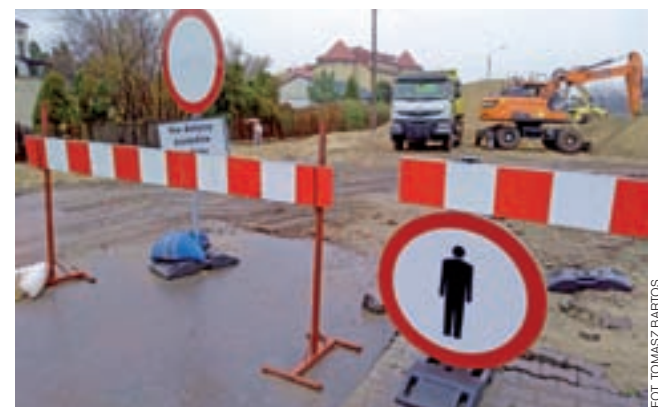
Na ulicy Warszawskiej, w rejonie budowy ronda stoją znaki informujące o zakazie ruchu pieszych.
