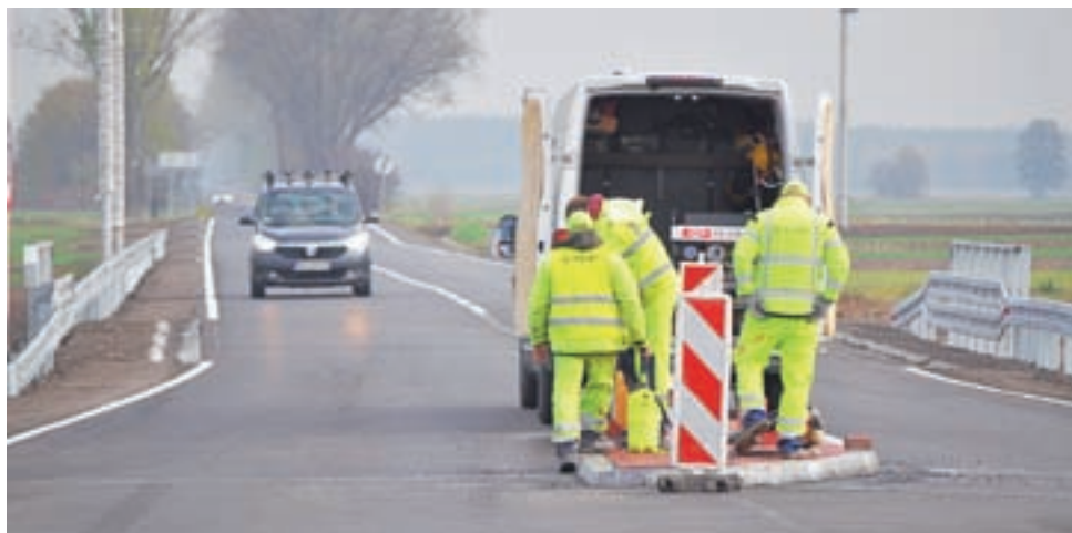
W ubiegłym tygodniu prowadzone były głównie roboty związane z malowaniem znaków poziomych oraz na wysepkach drogowych.
