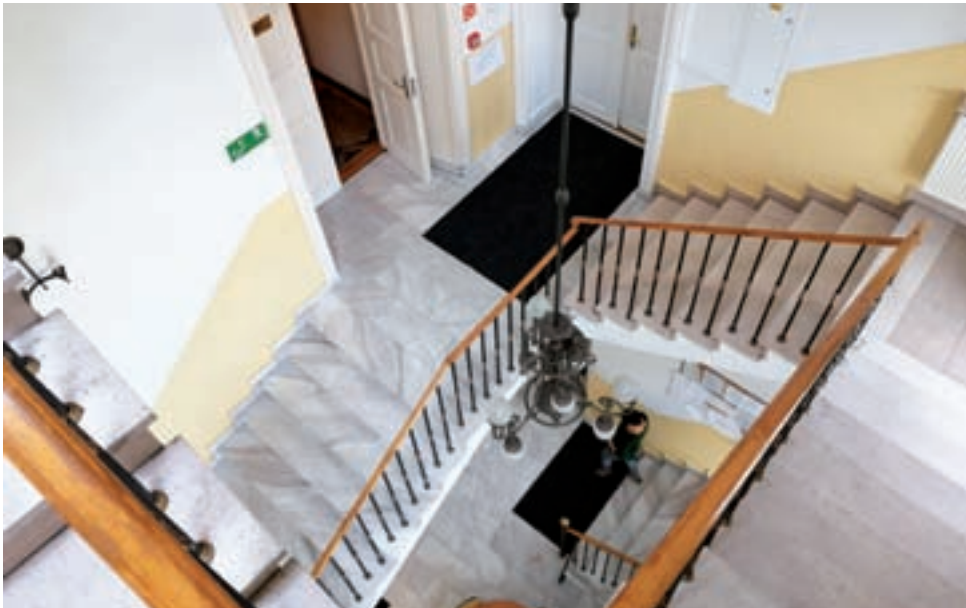
Klatka schodowa w łowickim ratuszu. Już niedługo w środku, pomiędzy schodami zostanie zamontowana winda.
