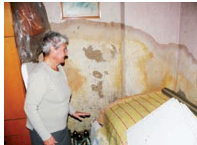
Pani Wanda pokazuje ścianę w pokoju, którego nie używa, do połowy jest ona zawilgocona, czuć przy niej pleśń.
