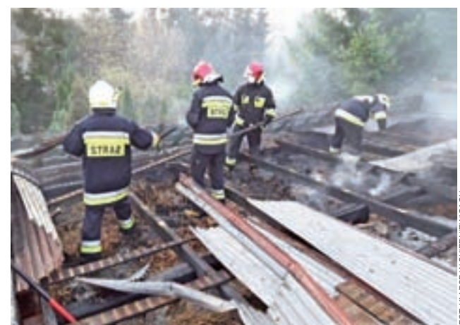
Strażacy rozbierają zniszczony dach budynku.
