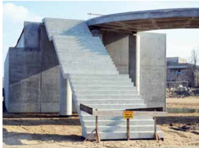
Fragmenty konstrukcji wiaduktu w ul. 3 Maja. Drogi dojazdowe do niego są budowane.
