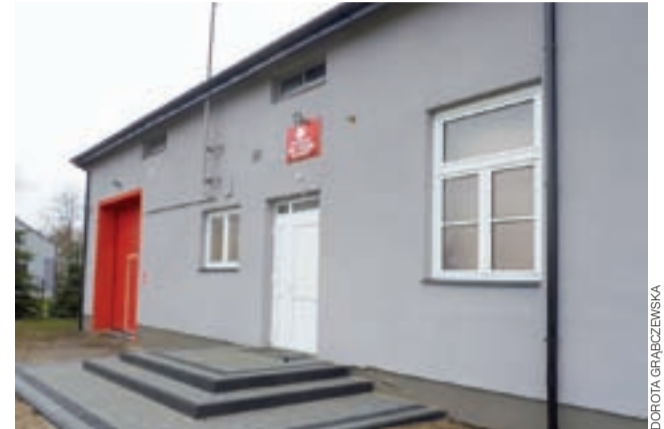
Strażnica w Skrzyszewach zyskała nowy dach z blachodachówki i częściowo nową elewację od strony frontowej i z jednego szczytu.
