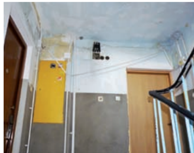
W bloku komunalnym przy Dąbrowskiego 6 zaczęto kompleksowy remont klatek schodowych.
