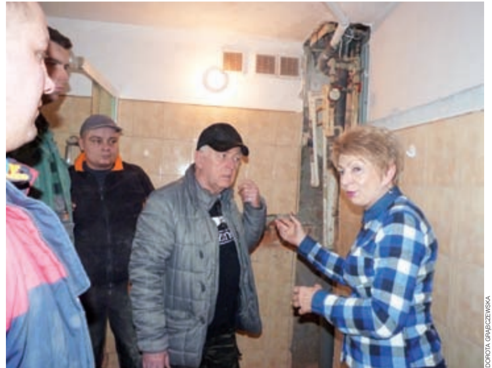
W piątek trwał remont pionu instalacji wodno-kanalizacyjnej w pomieszczeniach WZS.
