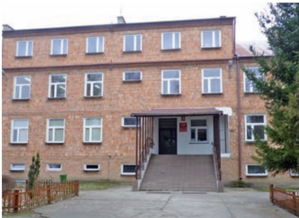
Na wiosnę rozpocznie się termomodernizacja budynku szkoły w Szczycie.
