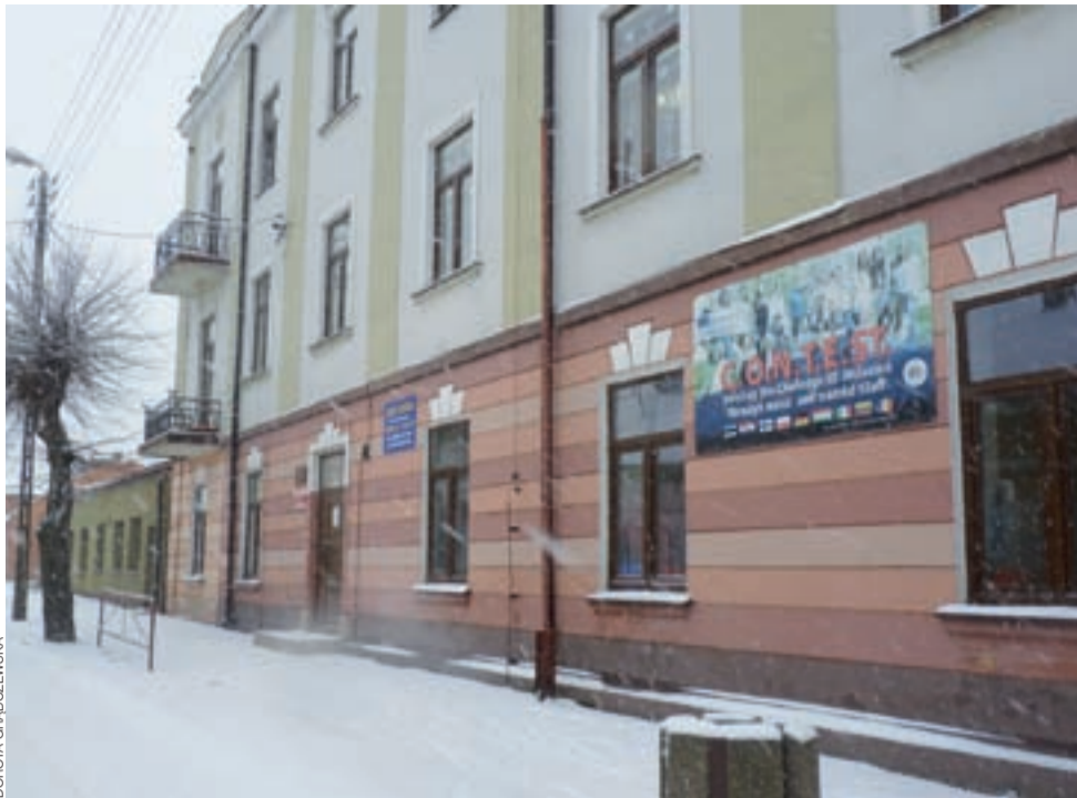
Z końcem sierpnia uczniowie z SP 1 opuszczają mury budynku przy ulicy 1 Maja. Teraz rozpoczyna się dyskusja, jak zagospodarować obiekt.
