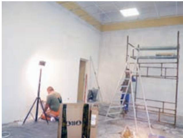
W świetlicy OSP Żychlin układana jest gładź gipsowa na ścianach oraz podwieszany sufit.
