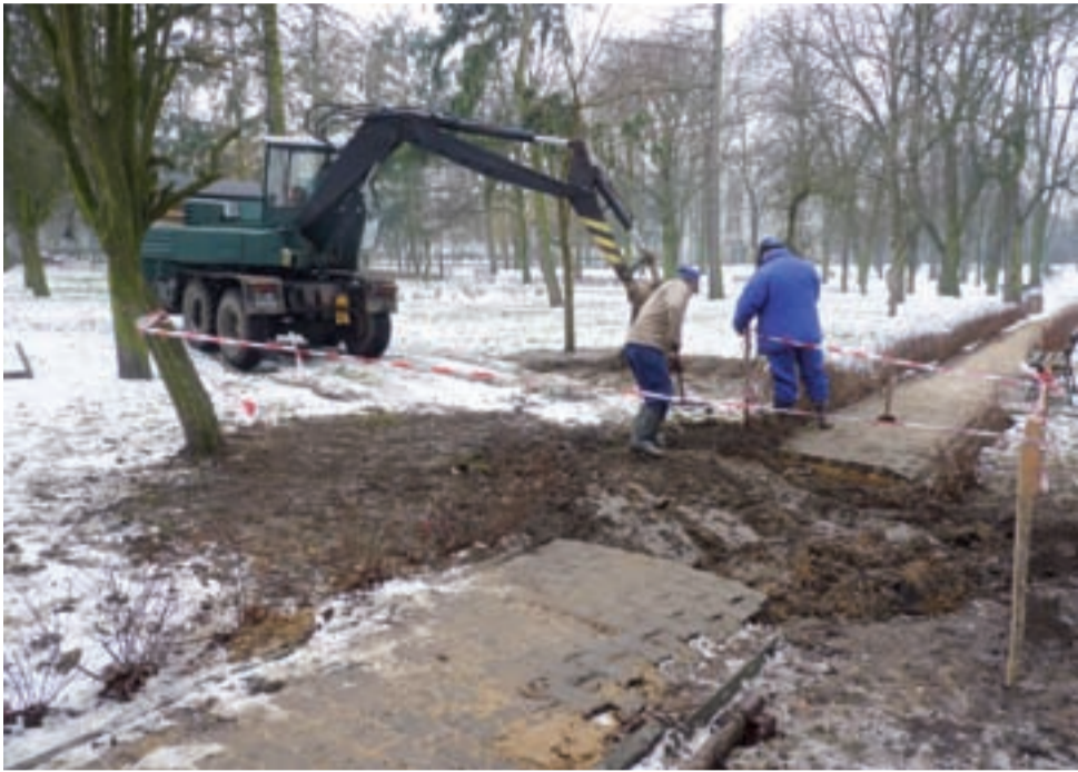
W parku przy Narutowicza rozebrano około 2 metrów chodnika, by wymienić skorodowaną rurę wodociągową.
