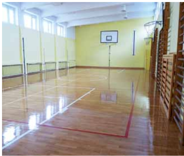
Parkiet w sali gimnastycznej w SP 2 poddano renowacji, by służył przez kolejne lata.
