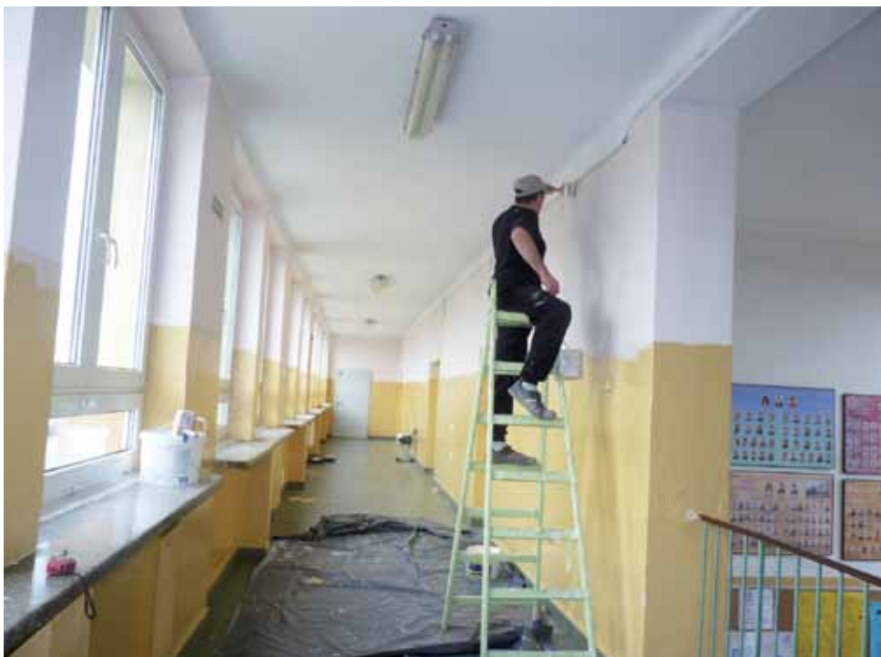
Trwa malowanie korytarza szkolnego na II piętrze.
