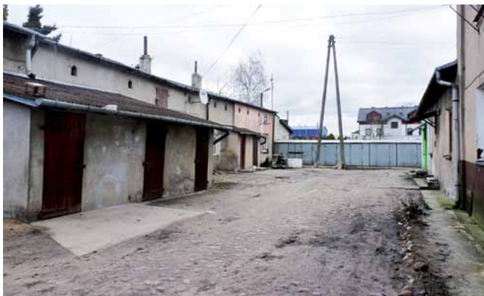
Mieszkańcy komunalnej kamienicy przy Jana Pawła II nr 17 mają nadzieję, że doczekają się w tym roku obiecanego remontu ich kamienicy.
