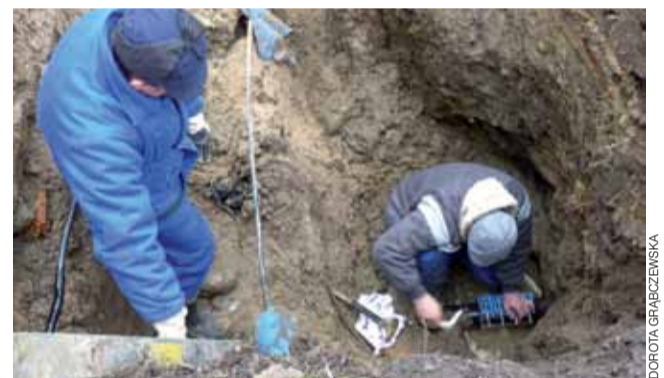
Pracownicy SZB uporali się z usunięciem awarii wodociągowej w ulicy Traugutta w ciągu kilku godzin.
