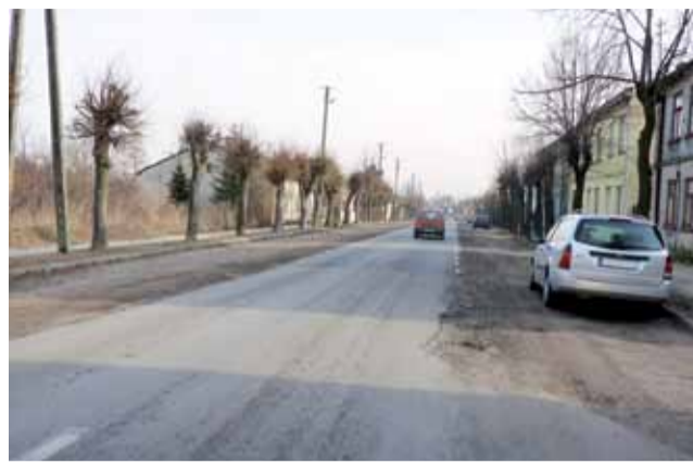
Dla poprawy bezpieczeństwa potrzebne jest poszerzenie drogi wojewódzkiej z Żychlina do Pacyny, przynajmniej na odcinku ul. Sannickiej.
