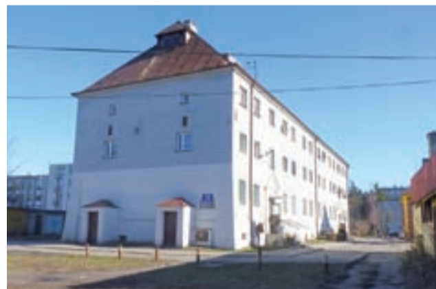
W tym roku spółdzielnia Wspólny Dom planuje remont dachu na bloku Narutowicza 75.
