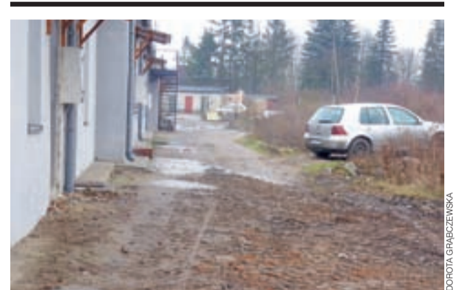
W tym roku SZB planuje utwardzić drogę wzdłuż kamienicy 1 Maja 40.
