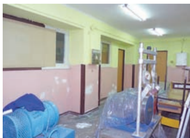
W czasie ferii w ZS trwało malowanie pomieszczeń klasowych znajdujących się w piwnicy.
