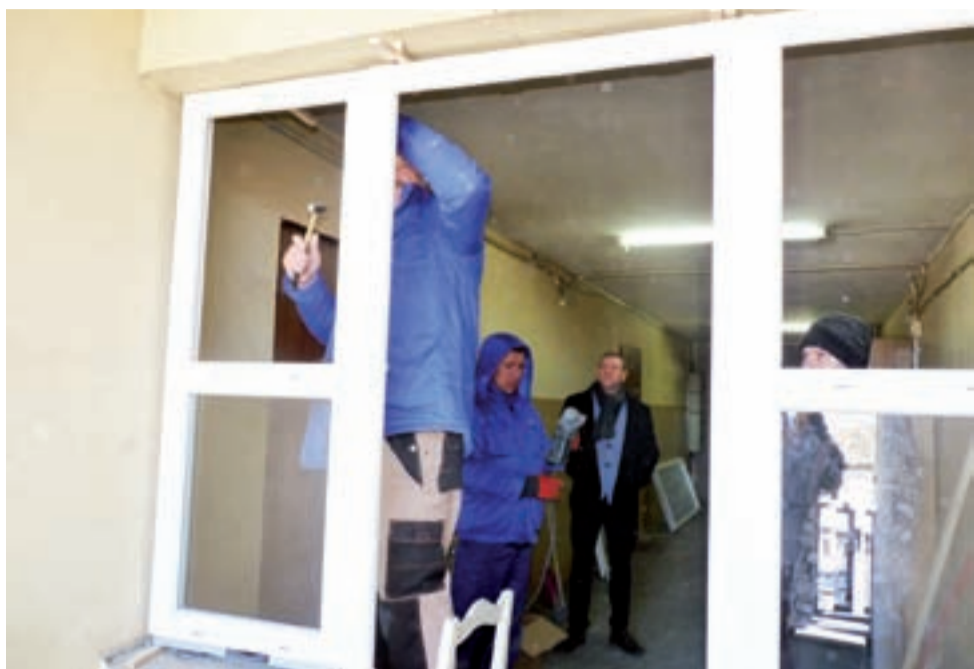
Okna na klatce schodowej bloku Konopnickiej 1 wymieniaли pracownicy spółdzielni.
