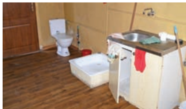
Toaleta, brodzik i umywalka (w tle drzwi wejściowe) – wszystko w jednym pokoju mieszkalnym o pow. około 20 m 2 .
