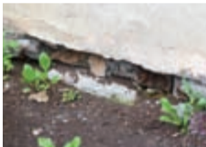
Fundamenty kamienicy komunalnej w sierpniu 2018 r.
