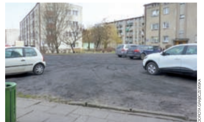
Wkrótce żuźlowy parking pomiędzy blokami na osiedlu Wyzwolenia zostanie utwardzony tuczniem. To wspólna inwestycja obu żychlińskich spółdzielni mieszkaniowych.
