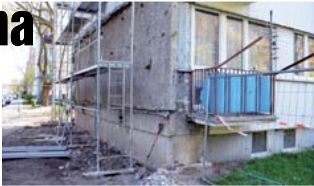
Żeby położyć nowe docieplenie, najpierw trzeba zerwać starą piankę pokrytą blachą.
