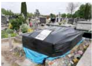
Zabezpieczony grobowiec w oczekiwaniu na dalsze prace konserwatorskie.
