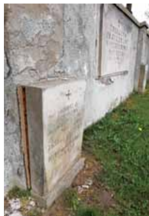
Odstająca płyta nagrobna od muru, z którego odpada tynk – to najgorzej wyglądające miejsce na kwaterze wojennej cmentarza katedralnego.
