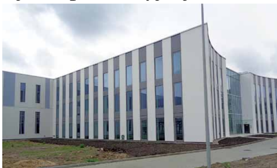
Nowoczesna hala produkcyjna jest już gotowa.
