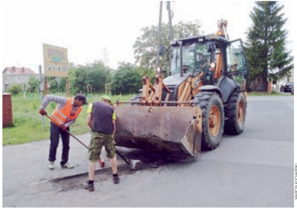
Roboty drogowe na ul. Słowackiego w Żychlinie.
