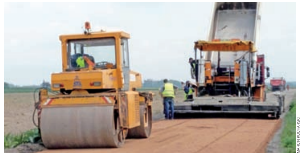
We wtorek po południu pracę na drodze Czesławów - Drzewoszeki przerwał deszcz.
