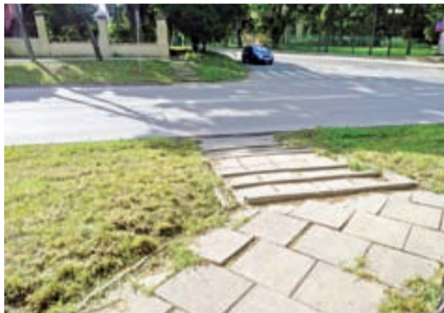
Chodnik i schody doprowadzą pieszych do miejsca, w którym... nie można przejść przez ulicę.
