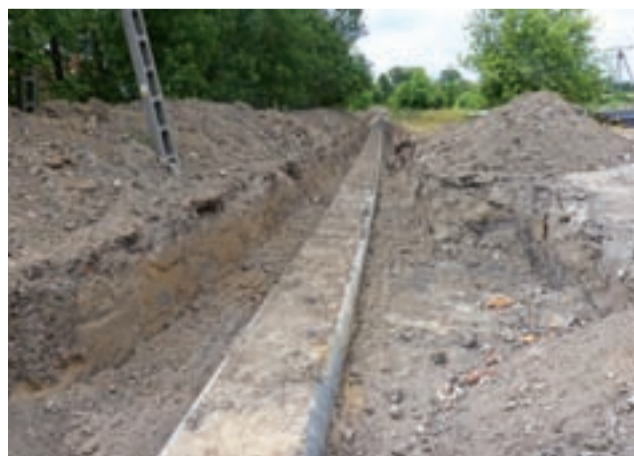
Fragment ciepłociągu wzdłuż rzeki Słudwi został już odkopany.
