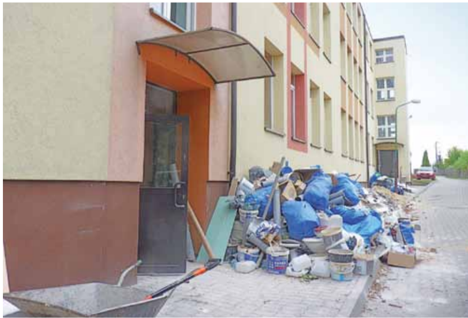
W trakcie remontu ZS nr 1 wywieziono 5-6 wywrotek gruzu i następnym czeka na wywiezienie.
