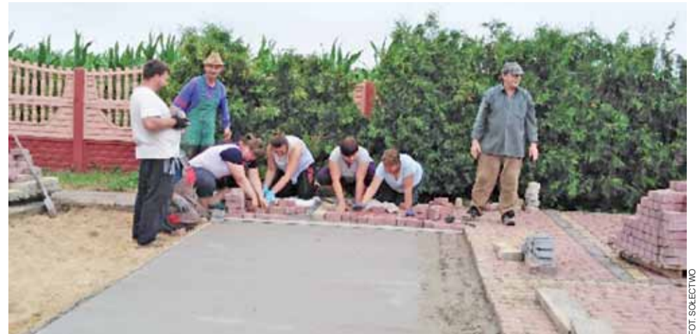
Mieszkańcy sołectwa Świechów sami układali kostkę brukową przed świetlicą wiejską.
