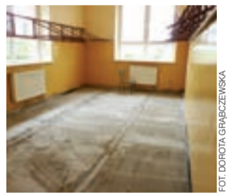
Trwa remont w szkolnej szatni. Wkrótce zostaną ułożone płytki.
