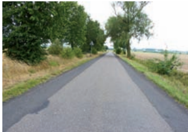
Droga powiatowa ze Skrzeszew do Sejkowic została poszerzona poprzez utwardzenie poboczy destruktem.
