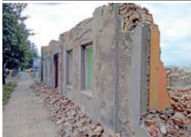
Stary budynek przy ul. Narutowicza został już wyburzony.
