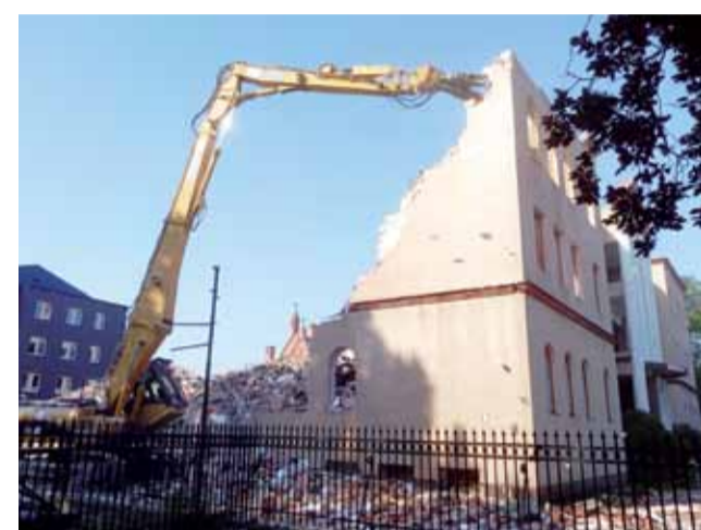
W ciągu dwóch dni z budynku zostało tylko tyle. Kolejne kilka dni miało trwać kruszenie większych elementów ścian i stropów.
