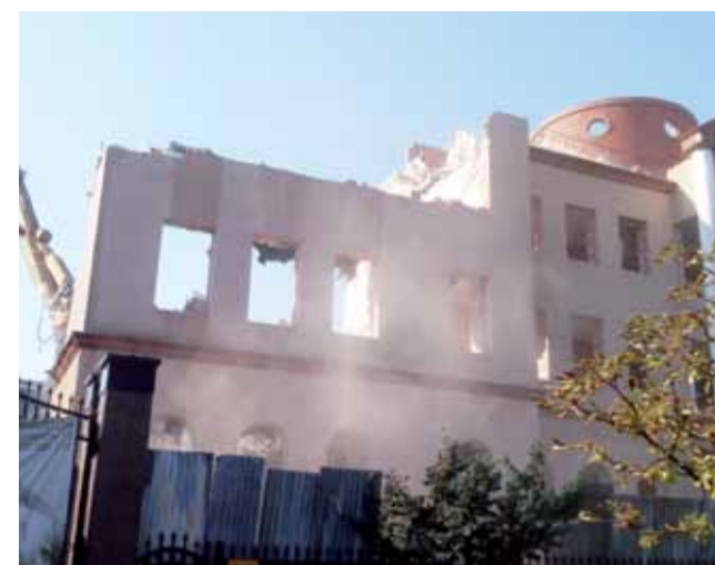
Budynek dosłownie „znikał w oczach”, gdy do pracy przystąpiła specjalna kruszarka.
