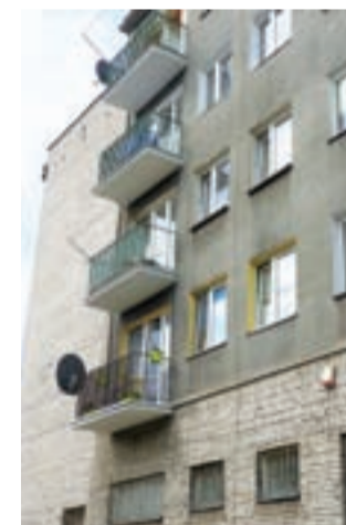
W bloku Narutowicza 71/I zmodernizowano wszystkie balkony.
