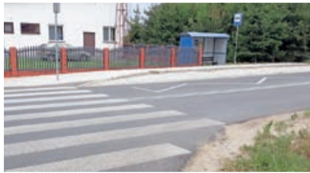
Jezioro w gminie Kocierzew Płd. Autobusy liniowe PKS na ten przystanek nie dojadą, chociaż prowadzi do niego przejście dla pieszych, a zatoka wyłożona jest nową kostką.
