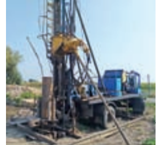
Budowa studni w Oszkowicach. Stan na 28 sierpnia.
