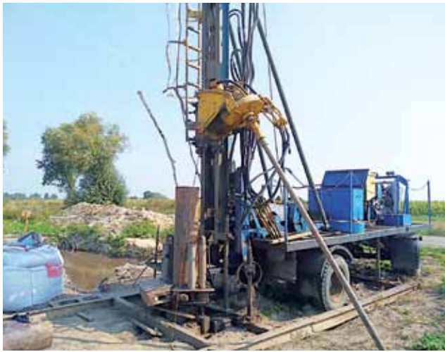
Budowa studni w Oszkowicach. Stan na koniec sierpnia.
