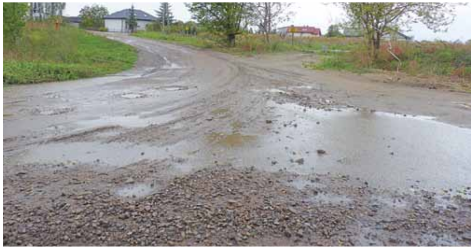
Wyprofilowana zostanie ulica Dolna oraz skrzyżowanie z ulicą Nową i Śląską.
