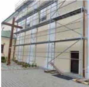
Wzdłuż kościoła w Żychlinie ustawiono rusztowania.
