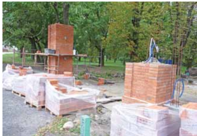
Trwa budowa fragmentu ogrodzenia wokół dworu Dobrzelin. W październiku zostanie zamontowana kuta brama
