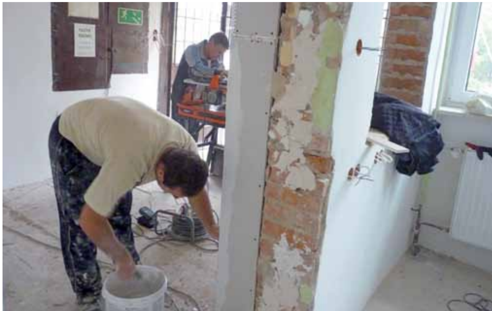
Trwa przebudowa dyżurki na posterunku w Pacynie.
