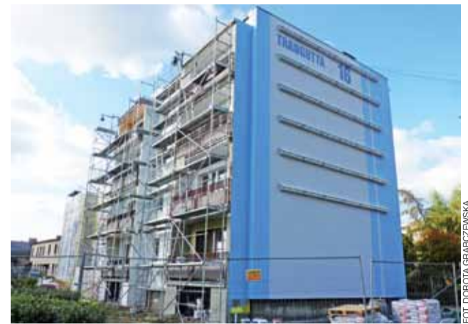
Termomodernizacja bloku Traugutta 16 jest na półmetku.
