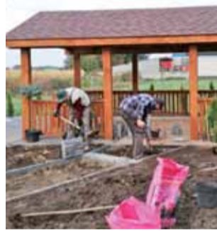
Sołectwo Pilaszków wzbogaciło się o nową altanę przy Domu Ludowym i remizie.
