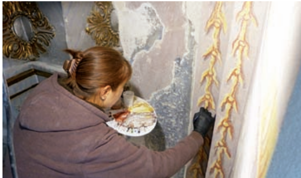
Waleria Karpiuk przy pracy nad renowacją ornamentu w górnej części zachodniej nawy.
