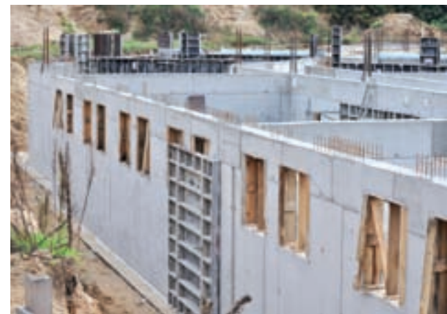
Dom Mocarzy ma już wymurowane piwnice, a siostry zbierają pieniądze na kolejne kondygnacje.
