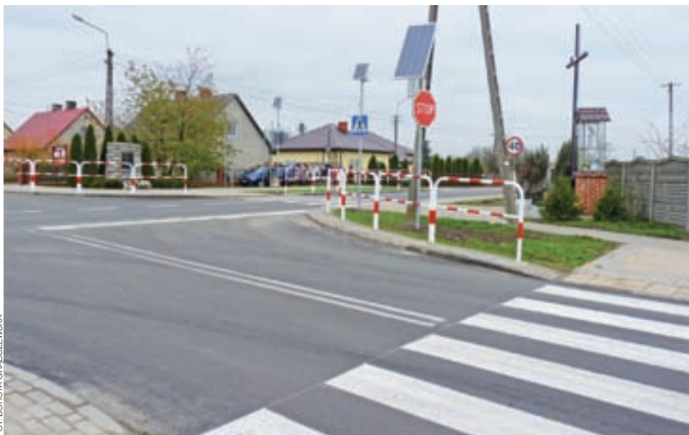
Po modernizacji skrzyżowanie w Trębkach, dwóch dróg powiatowych, prowadzące w stronę A1 jest bezpieczne. Są przejścia dla pieszych oraz podświetlane znaki dla kierowców oraz bariery ochronne.
