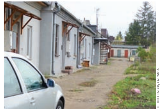
Mieszkańcy komunalnej Fabianówki czekają na dokończenie elewacji budynku oraz na utwardzenie drogi wzdłuż nieruchomości.
