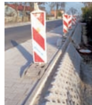
Fragment nowego chodnika oraz zabezpieczenie skarpy w Chruślinie w gminie Bielawy.
