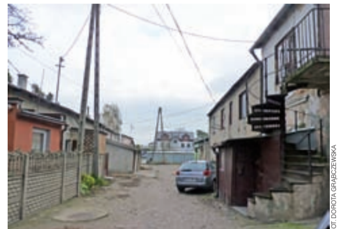
Mieszkańcy kamienic komunalnych przy ul. Jana Pawła II nr 17 czekają na obiecany remont.
