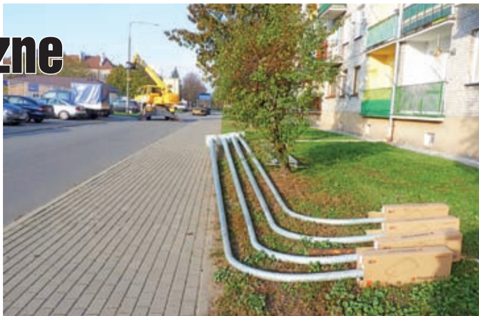
W ulicy Waryńskiego energetycy wymieniali stare słupy oświetlenia ulicznego zamieniając je na nowe ocynkowane z lampami LED.
